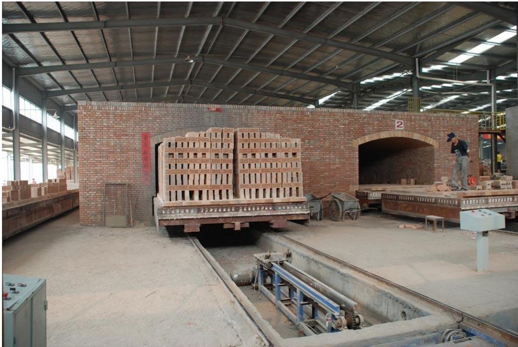
Figura 2. Horno tipo Túnel.
